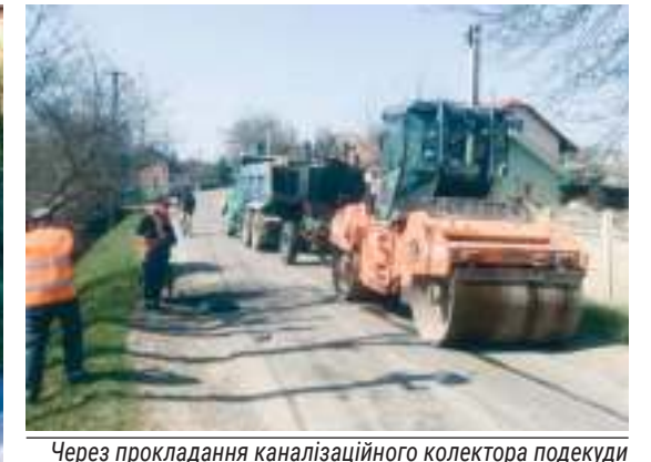
Через прокладання каналізаційного колектора подекуди роблять тільки ямковий ремонт
